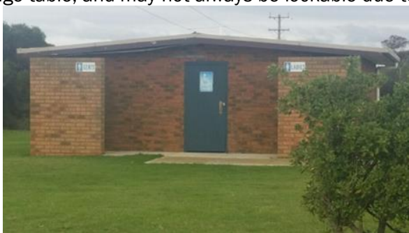
000368 Lang Lang Jetty Lane
